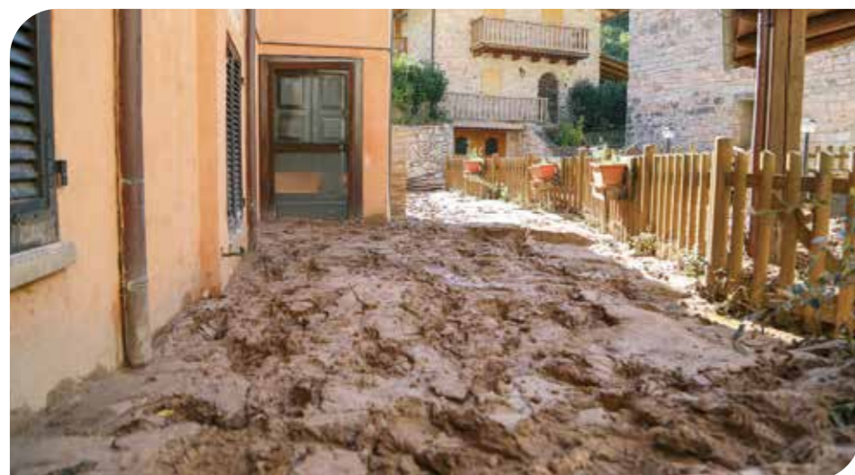
Alluvione Marche. Frontone (PU), 19 settembre 2022 – I danni causati dall'alluvione che ha colpito le Marche il 15 settembre scorso
